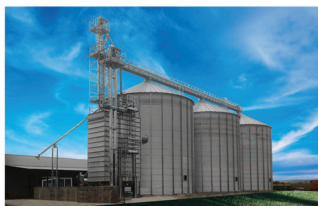
Impianti di stoccaggio
